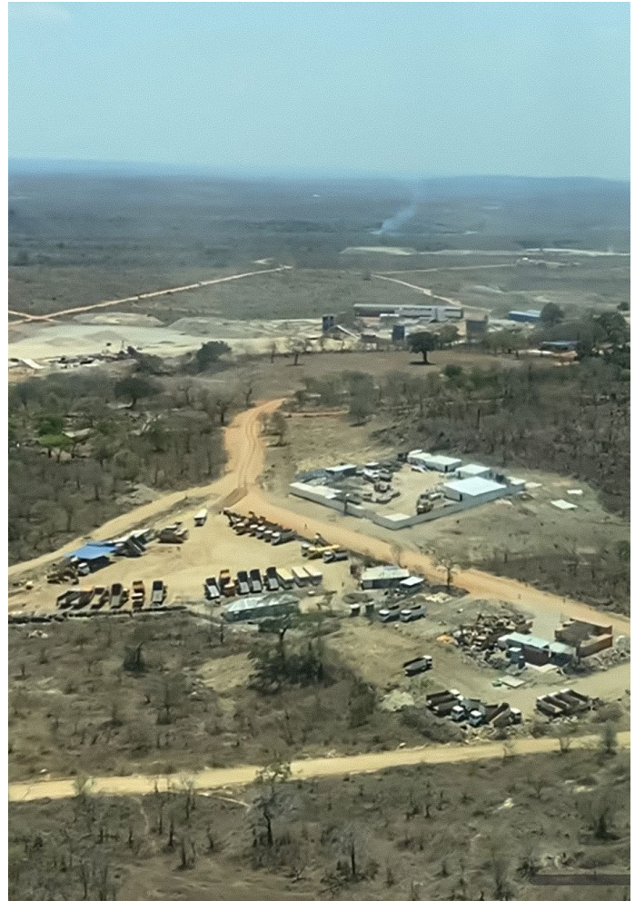
Die Baustelle des Nyerere-Staudamms an der „Stieglers Schlucht“ im November 2020.
